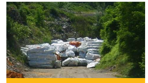
Sicher verpackte KMF und Asbest
